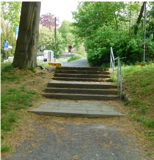
Abb. 22: Treppenverbindung zur Parkstraße
