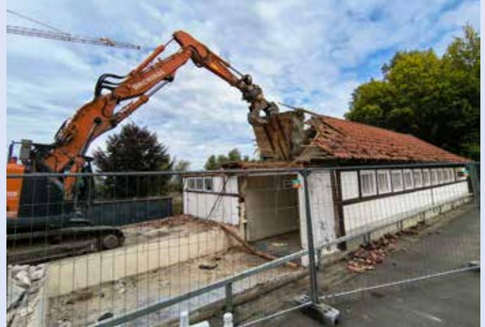
Im Rahmen der Freibad-sanierung startete ab Montag, 8. September 2025, der zweite Bauabschnitt. Nun ist der obere Eingangsbereich des Bades dran. Dort wird ein neues Multifunktionsgebäude entstehen, welches die alten Gebäude ersetzt. Die Abrissarbeiten sind in vollem Gang.
