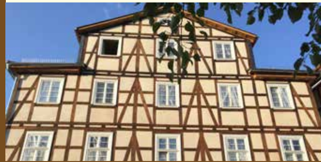
Sanierte Fassade, aufgewertet durch die Fenster
