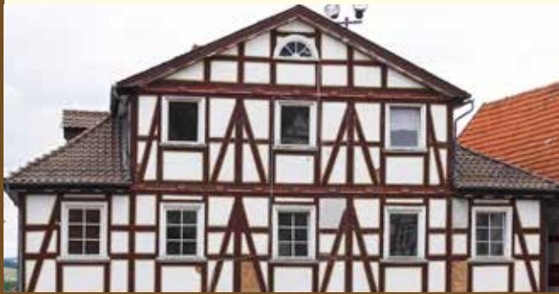
Unsanierete Fassade, verunstaltet durch die Fenster
